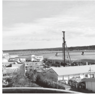
建設中の厚岸漁協貯氷・冷蔵保管施設
