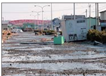
津波後の厚岸町の様子
