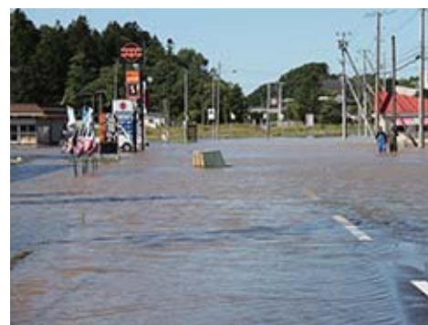
平成25年9月16日の台風18号の影響で、門静地域が冠水。上水道の取水ポンプ場も冠水し、取水ポンプに動力を供給する配電盤が水没して取水不能に。約4,100世帯が2日間にわたり断水を余儀なくされました。
