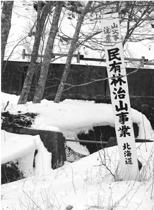
御供山に設置されている治山ダム
