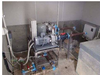
望洋台ポンプ場給水ポンプ整備工事 給水ユニットを更新
