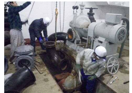
厚岸浄水場洗浄ポンプ用弁類整備工事 ポンプの大型弁類を更新
