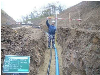
床潭末広間道路送配水管布設替工事 耐震型水道管で布設替
