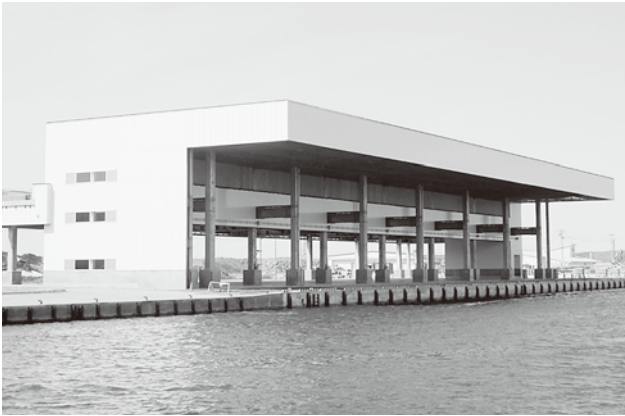
完成が待ち遠しい荷捌所
