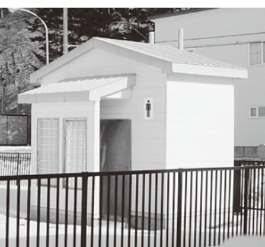
利用されていない使用禁止のトイレ
