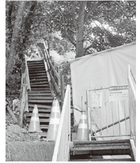
御供山避難階段設置工事
