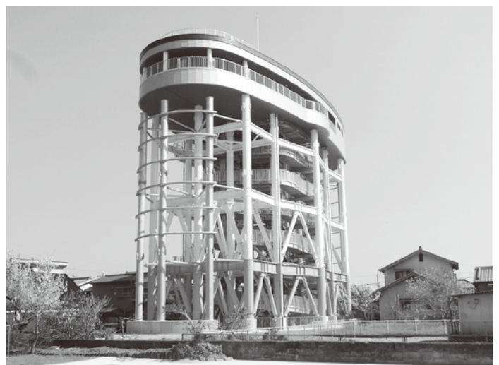
津波避難タワー（黒潮町）
