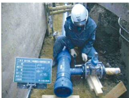
若竹第二埠頭配水管新設工事
