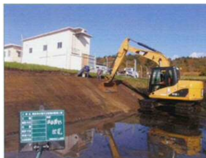
厚岸浄水場天日乾燥床整備工事
