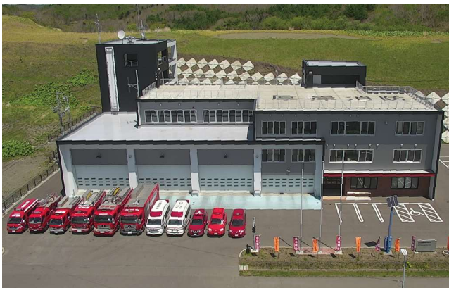
▼釧路東部消防組合 厚岸消防署庁舎
