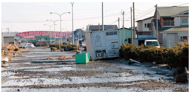
▼津波後の漁港道路の様子(若竹)
