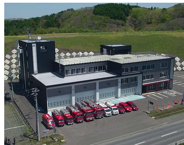
厚岸消防庁舎を高台に移転しました。 新庁舎は、町の災害対策本部機能を備えています。 (厚岸消防庁舎)
