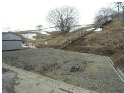
↑ 建設用地造成 施工後
