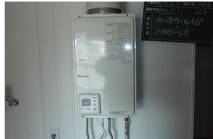
↑ 給湯器更新(更新後)
