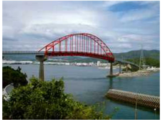
（下松市街地と笠戸島を結ぶ笠戸大橋）
