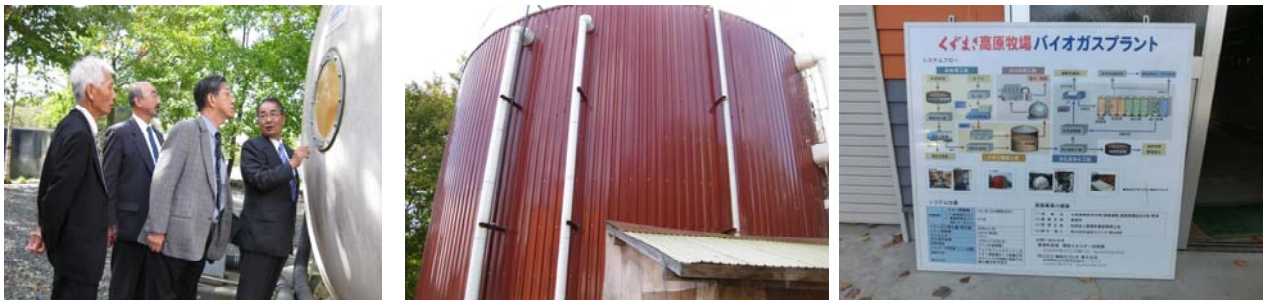
くずまき高原牧場内にある畜ふんバイオマスシステム
