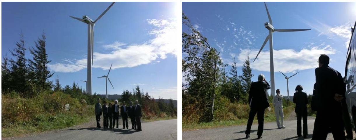
標高1,000メートル超にある「グリーンパワーくずまき風力発電所」
