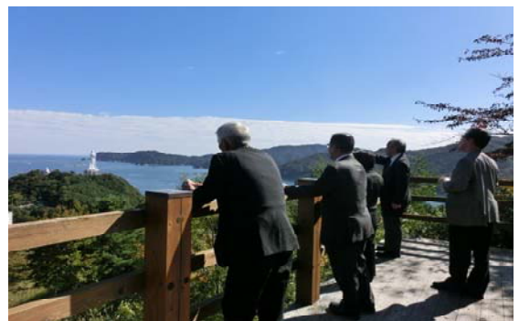
展望台から修復作業中の湾口防波堤を望む
