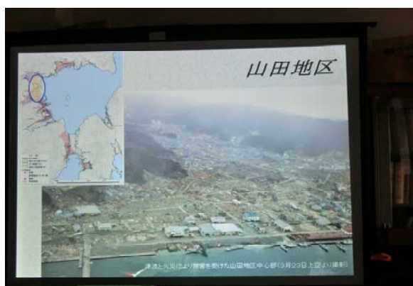
上空から見た被災後の町中心部
