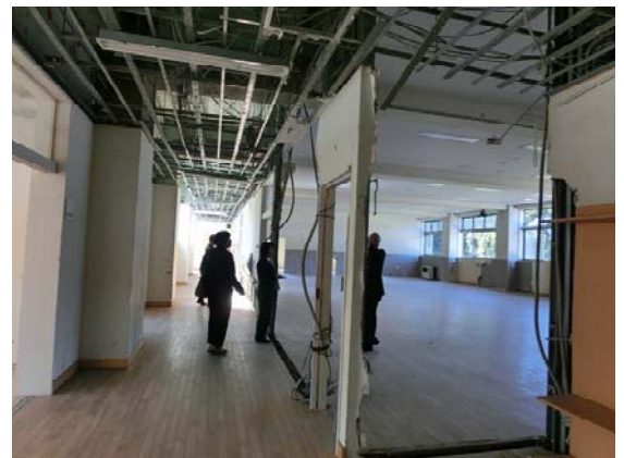
217、8名もの犠牲者が出た防災センター内部
