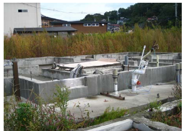
市内で倒壊し土台だけとなった建物
