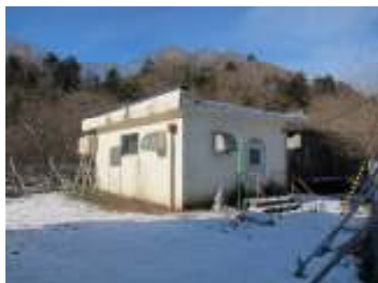
普段の取水ポンプ室の様子。被災時の水位は建物の 3 分の 2 の高さまで達しました。
