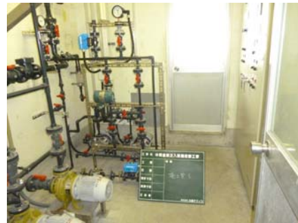
厚岸浄水場の中間塩素注入設備を改修しました
