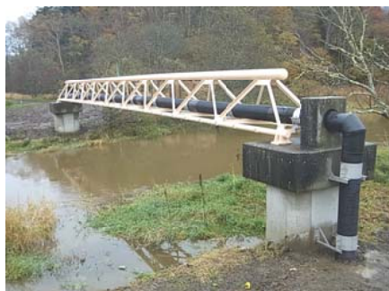
旧尾幌1号川に架かる水管橋の配水管を取り替えました
