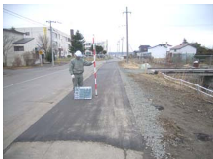
湾月町横3の通りの配水管を取り替えました
