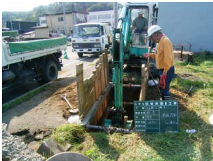
町内5カ所で老朽化した仕切弁を取り替えました
