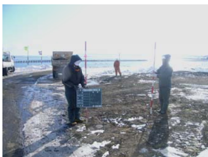
門静前浜道路に配水管を新設しました
