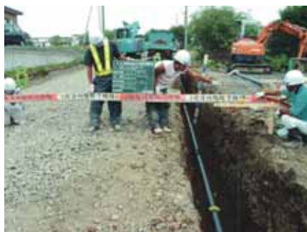
望洋台6号通り外1配水管布設替工事。道路工事に伴い配水管の布設替えを行いました。
