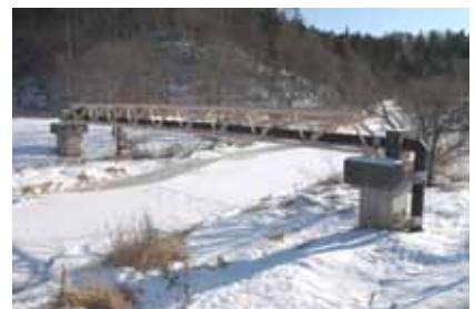
【上】尾幌川に架かる水管橋。古い水道管を再利用した支持材に抱えられた黒い部分が水道管
