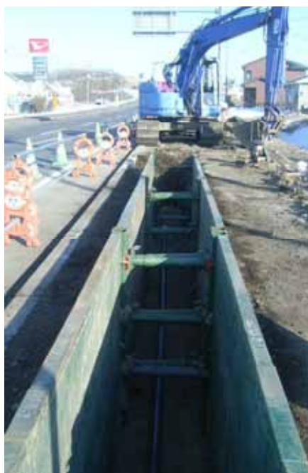
白浜町6号通り外配水管新設工事。白浜地区の国道44号変電所バス停付近から白浜町4号通りまで、未整備箇所に配水管を新設しました。
