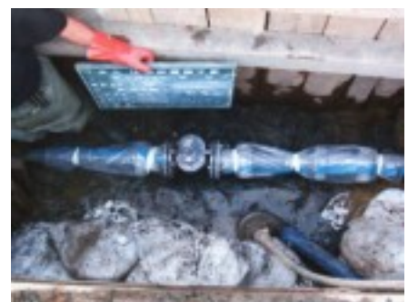
仕切弁整備工事。町内6箇所の老朽化した仕切弁を更新した。
