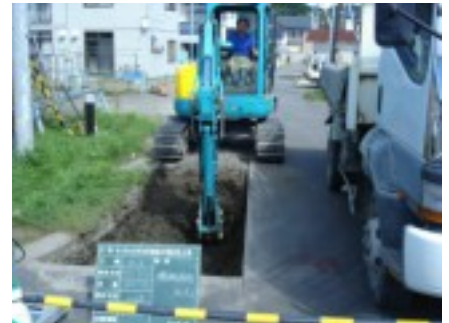
住の江町11号線配水管新設工事。水道管を新設し、周辺地区の水圧不足を解消した。
